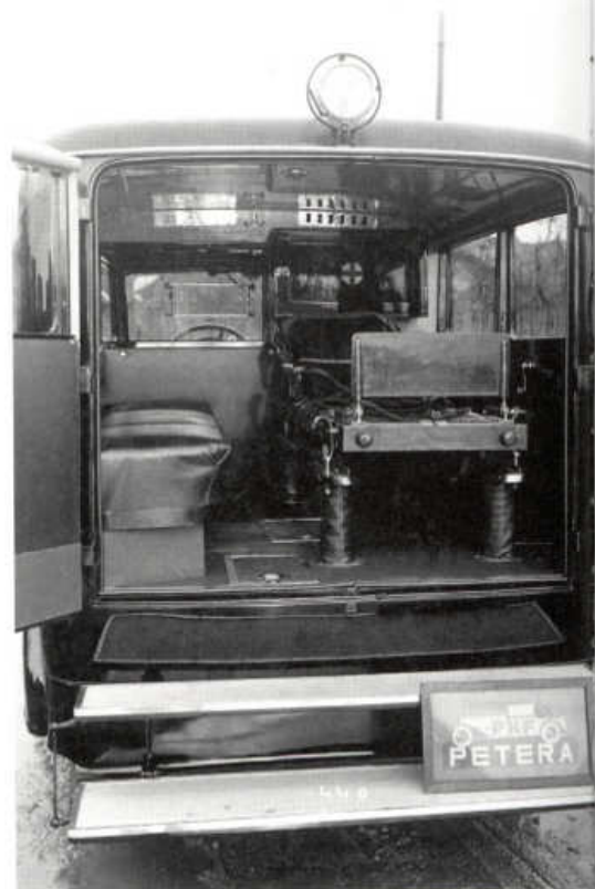
Interiér sanitky s odpruženým lůžkem od firmy Petera
