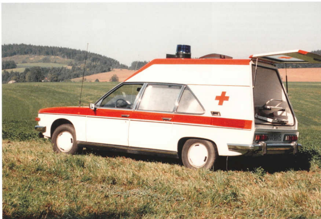
Zvýšená nástavba první sanitka Ing. Frimla měla nahoru vyklápěcí dveře v zádi
