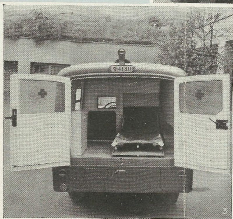
Bild 4: Ausgefahrene Schiene und Trage mit gefeder-ten Laufrollern ermöglicht durch Schwenkung (Bild 5) ein sicheres Ein- und Ausladen.
