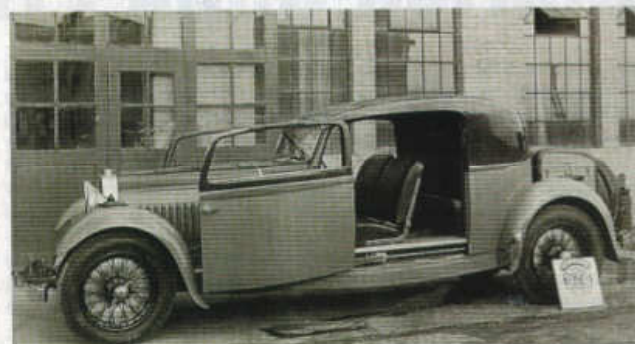
Specialitou Lobkovicovy bugatky byly posuvné dveře údajně švýcarské konstrukce.
