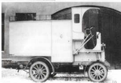
Skříňový vůz pro černoohorskou poštu se sedadlem řidiče nad motorem
