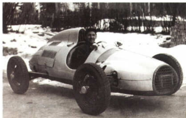
Mono JK měl původně dostat dva spřažené motory KdF, zůstalo však jen u jednoho.
