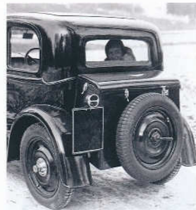
Typická zád tudoru Škoda 420 s plechovým „kufrům“ nesoucím náhradní kolo
