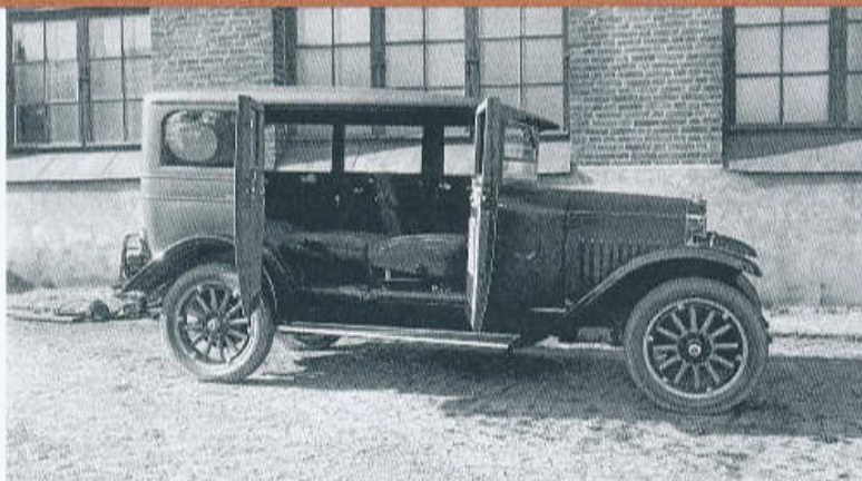
▼ VOLVO PV 4 Z ROKU 1929 BEZ STŘEDNÍCH SLOUPKŮ S LŮŽKOVOU ÚPRAVOU SEDADEL
