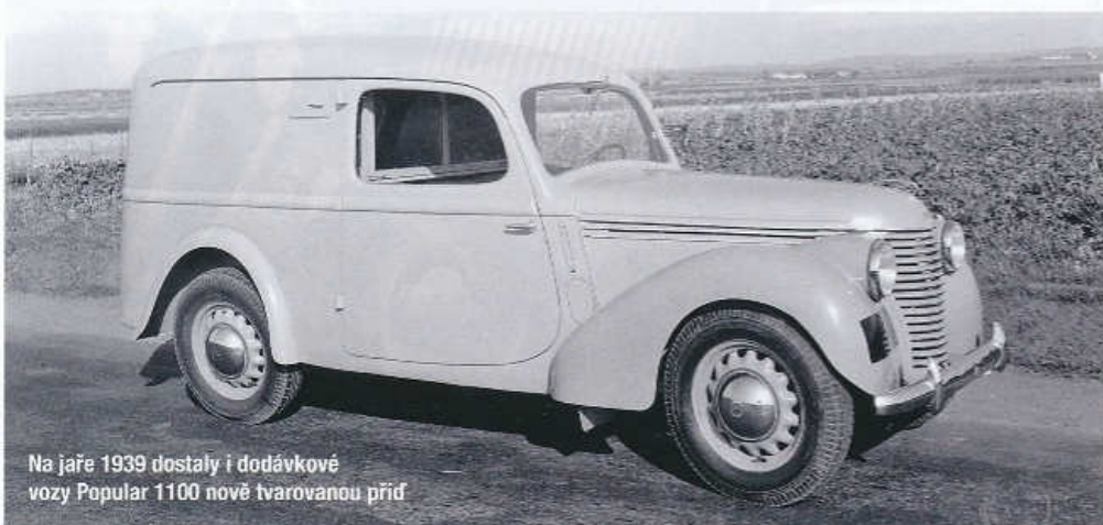
Dodávka se zesíleným podvozkem měla užitečnou hmotnost 500 kg (1939)
