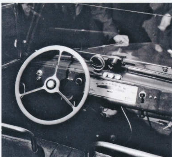
Pony II měl velmi optimistický rychloměr se stupnicí do 160 km/h
